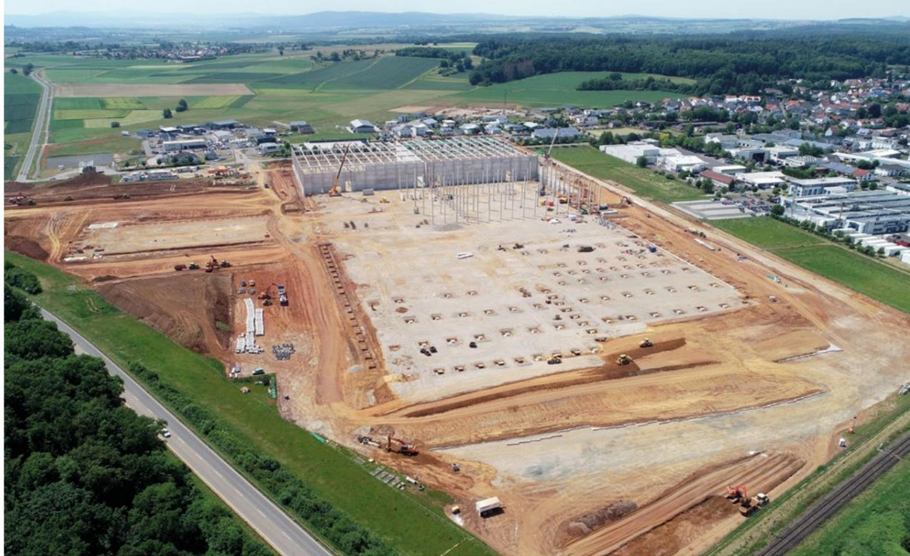
Imposante 90.000 Quadratmeter Lagerfläche unter Dach: Das Logistikzentrum Lich ist bisher das größte von Bickhardt Bau erschlossene Bauvorhaben dieser Art (Foto oben). Der Einbau des Frostschutzplanums erfolgt mit einer GPS-gesteuerten Raupe unter Dach (kleines Foto unten).
