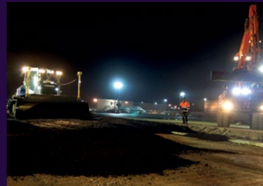
Mit einer Raupe wird die erste Lage der Asphalt-Tragschicht eingebaut. Die vorher verlegten GFK-Rohre sind gerade noch so zu erkennen.
