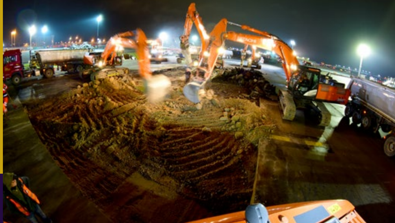
Mit vereinten Kräften wird die Oberfläche der Asphalt-Rollbahn aufgebrochen und 80 Zentimeter tief ausgehoben. Das Material wird auf Sattelzüge geladen, die es auf eine Lagerfläche außerhalb der Vorfelder bringen. Dort wird es aufbereitet und kann später wieder eingebaut werden.
