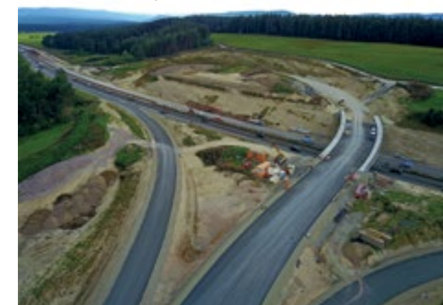
Die neue Anbindung an die Autobahn 71.
