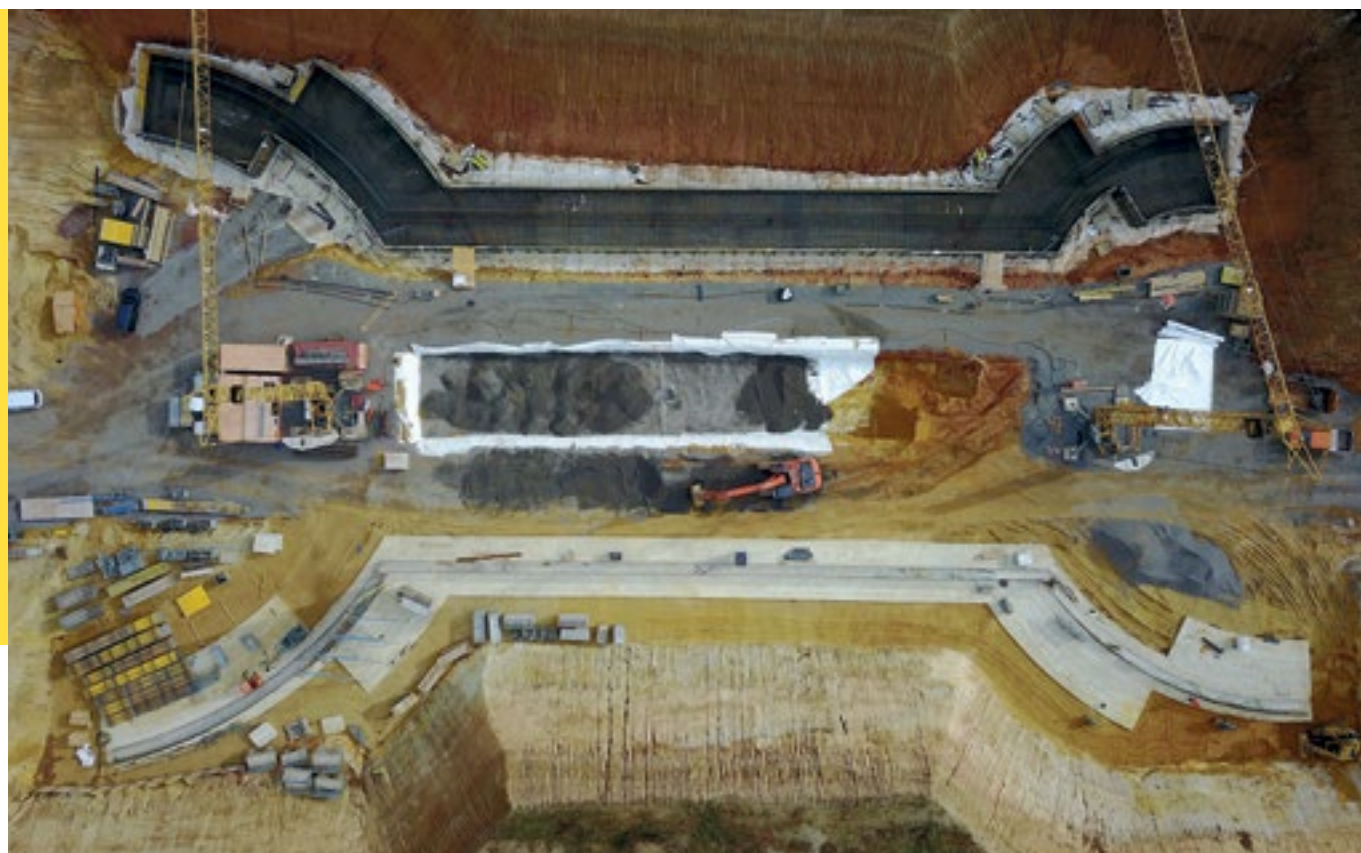
Die Fundamente der Grünbrücke sind ein interessanter Anblick aus der Vogelperspektive: Während im oberen Bereich (dunkel) noch die stehende Schalung mit dem Bewehrungsstahl zu erkennen ist, erfolgte auf der anderen Seite der späteren Autobahn bereits die Betonage des Fundaments.
