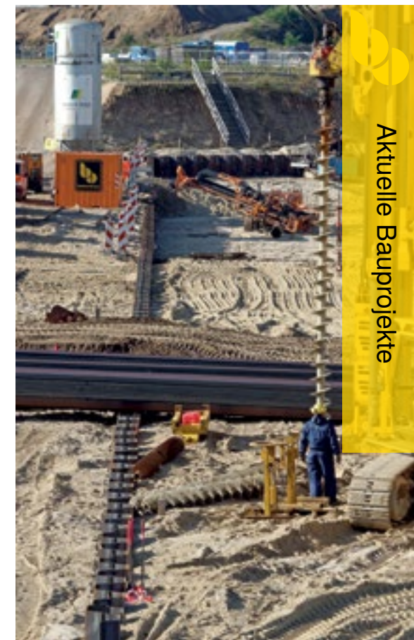
Großbohrgeräte, Rammen und Mäkler beherrschten in den vergangenen Monaten die Szenerie an der Großbaustelle für das neue Terminal 3 im Süden des Frankfurter Flughafens. Rund 7.100 Tonnen Stahlbohlen wurden in den Boden eingebracht, um die Baugrube herzustellen. Hoch anstehendes Grundwasser macht den Einsatz von Tauchern erforderlich.
