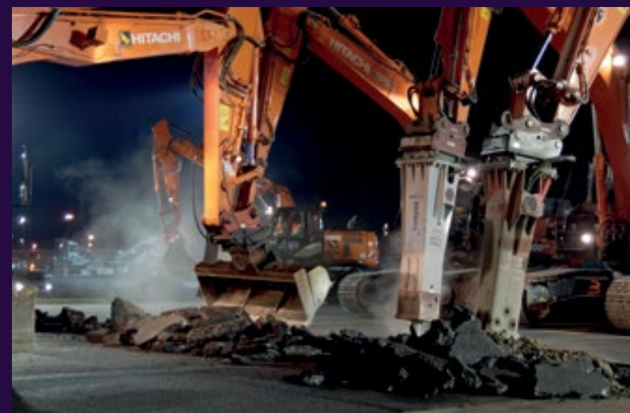
Aufbruchstimmung: Mit schweren Meißeln wird die Oberfläche des Rollweges im Eiltempo aufgestemmt. Der nächtliche Zeitplan ist eng gesteckt.
