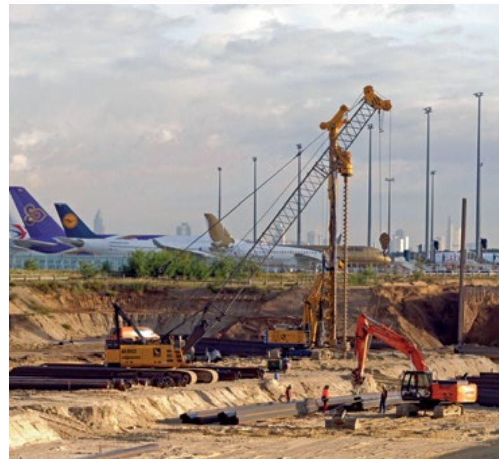
Großbohrgeräte, Rammen und Mäkler beherrschten in den vergangenen Monaten die Szenerie an der Großbaustelle für das neue Terminal 3 im Süden des Frankfurter Flughafens. Rund 7.100 Tonnen Stahlbohlen wurden in den Boden eingebracht, um die Baugrube herzustellen. Hoch anstehendes Grundwasser macht den Einsatz von Tauchern erforderlich.
