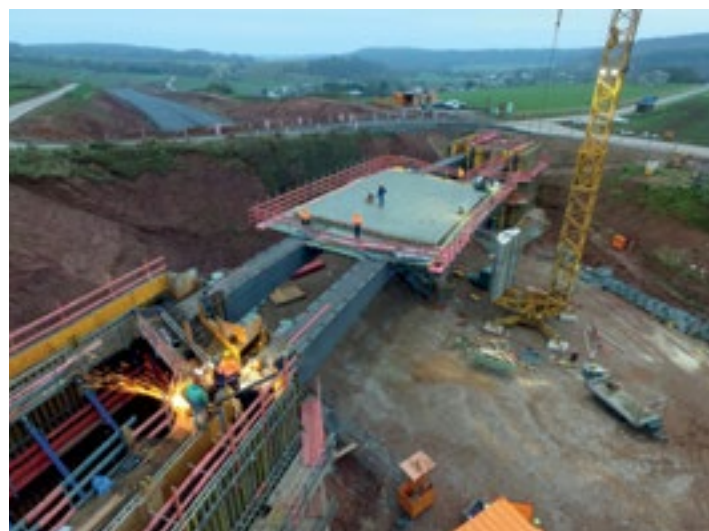
Die neue Überführung für die Verbindungsstraße zwischen Schlierbach und Einrode. Vier Stahlträger wurden vor Ort miteinander verschweißt, der Mittelabschnitt Ende des Jahres betoniert.
