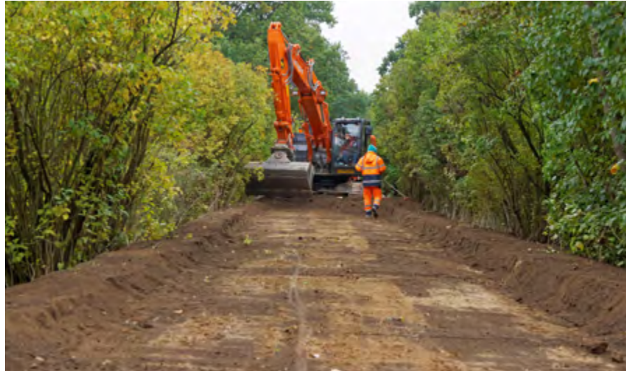
Beengter Arbeitsraum: Die Krone des Fliederwalls bietet gerade einmal Platz für einen kleinen Kettenbagger. Rechts und links geht es einige Meter in die Tiefe.
