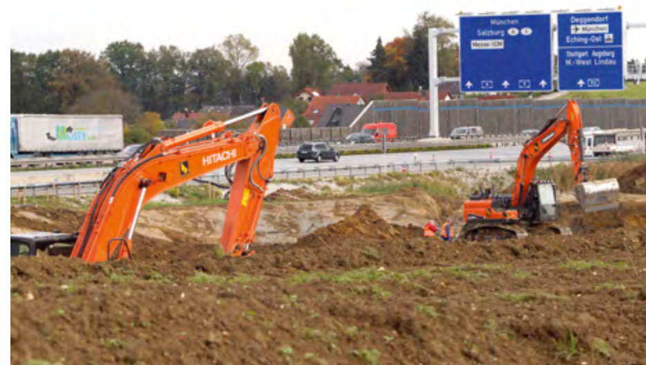
Vor den Toren Münchens wird die Tank- und Rastanlage Fürholzen erweitert. Zwei Bickhardt Bau-Bagger beim Aushub eines Rückhaltebeckens auf der Westseite.
