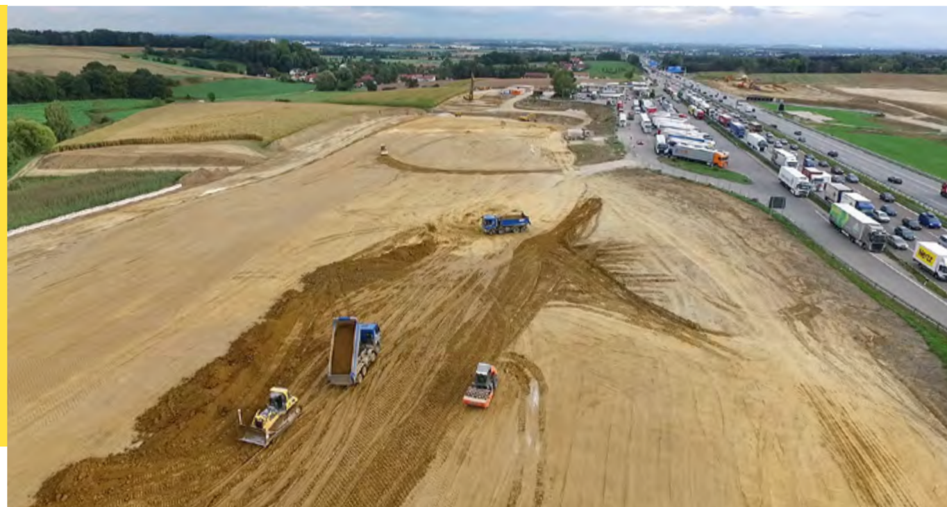
Blick auf die Erweiterungsflächen auf der Ostseite der Tank- und Rastanlage Fürholzen. Der Screenshot aus einem Überflugs-video, das die Bauüberwachung Dost Ingenieurleistungen mit einer Drohne aufgezeichnet hat, verdeutlicht die Dimensionen des Ausbaus. Während der Erdbau auf vollen Touren läuft, geht der Betrieb auf dem Rastplatz gänzlich ungestört weiter.
