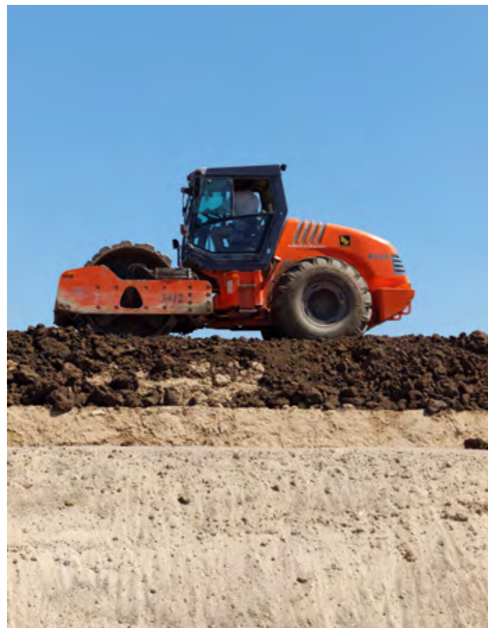
Die hohe Kunst des Erdbaus: Im Deichbau werden verschiedene Bodenarten qualifiziert eingebaut. (Foto links) Zum Schutz seines Dessau-Wörlitzer Gartenreichs ließ Fürst Franz Deiche entlang der Elbe errichten. Der Fliederwall (Foto rechts) wurde inzwischen von Bickhardt Bau mit einer Dichtungsschlitzwand ertüchtigt.
