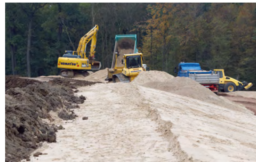
Großflächiger Erdbau mit Raupe, Bagger und Walze. Der Einbau erfolgte immer in kleineren Abschnitten, um bei Hochwasser schnell reagieren zu können (Foto oben). Achtung Klappe: Das Filmteam hat bei den Dreharbeiten im Sommer einen Kettenbagger in den Fokus genommen (Foto links).
