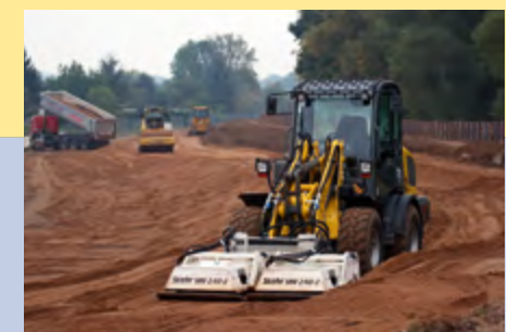
In dem engen Baufeld, teils mit angrenzender Bebauung, wurde mit Plattenverdichtern die nötige Verdichtung erreicht. (Foto: StehrTV)
