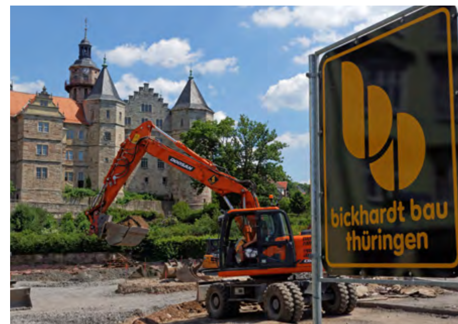
In Schleusingen stellen die Mitarbeiter von Bickhardt Bau Thüringen unterhalb des Schlosses Bertholdsburg einen Kreisverkehr her. Wenige Meter davon entfernt haben sie neue Bushaltebuchten angelegt.
