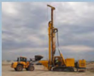
29.000 m Rüttelstopfsäulen wurden hergestellt, insgesamt 3,1 Mio Kubikmeter Boden verbessert.
