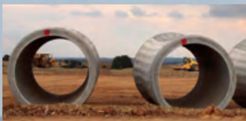
Für die Entwässerung sorgen 38.500 m Rohrleitungen mit Durchmessern von DN 160 bis DN 1400 und 550 Schächte.
