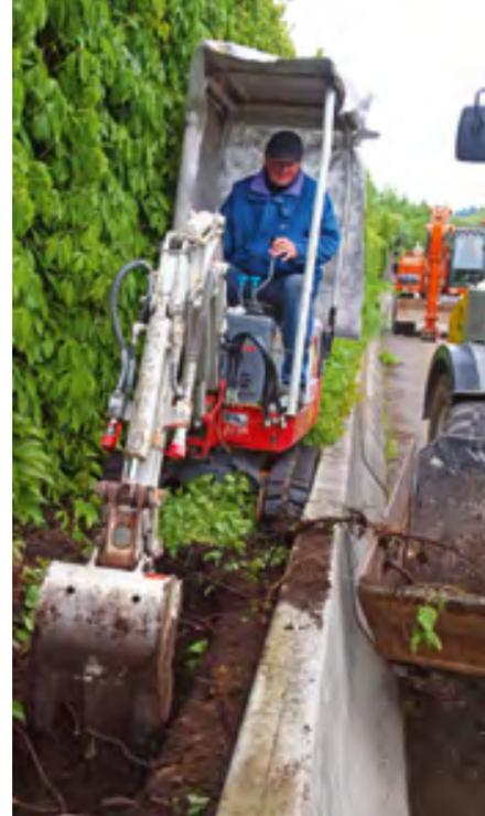
Blick von einer Fußgängerbrücke zum Tunnelportal Ost (Foto links). Der kleinste Bagger der Unternehmensgruppe im Einsatz zwischen Lärmschutz- und Betongleitschutzwand. Die Maschine stellte ihre wahre Größe beim Verlegen von Kabelschutzrohren eindrucksvoll unter Beweis.
