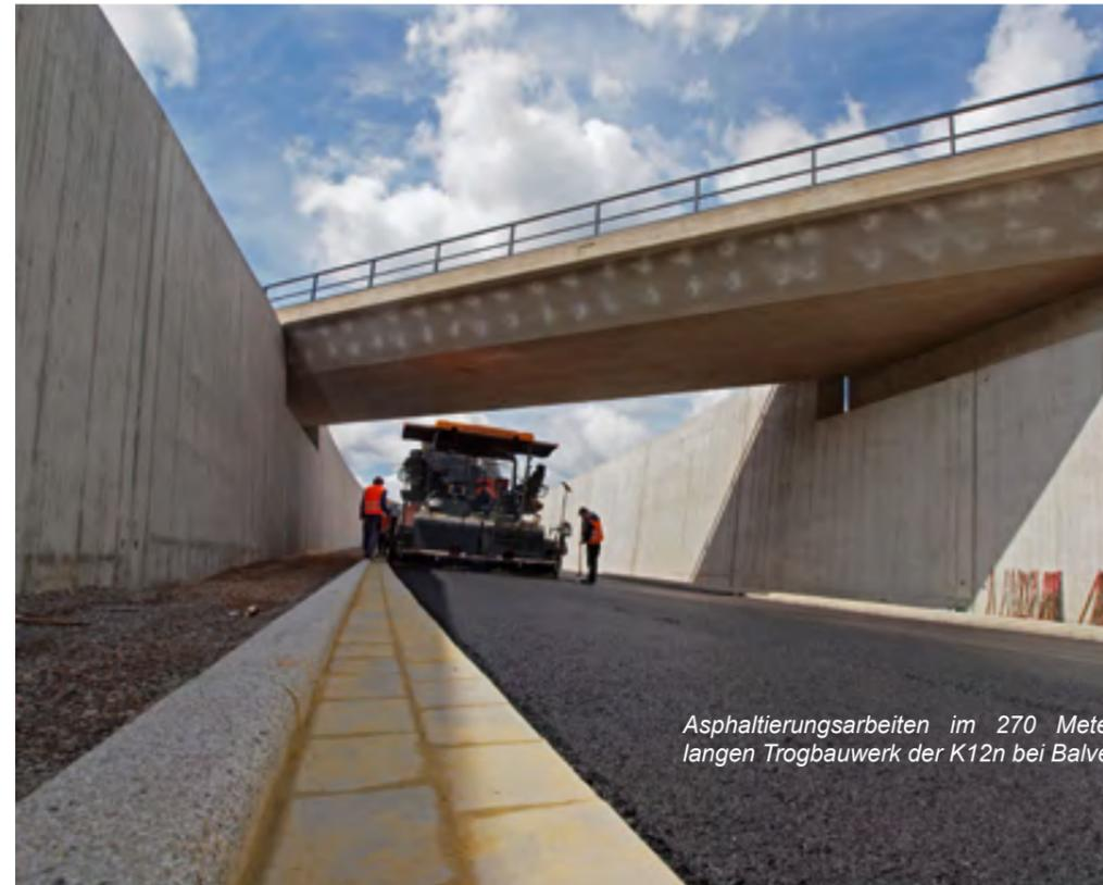
Asphaltierungsarbeiten im 270 Meter langen Trogbauwerk der K12n bei Balve.
